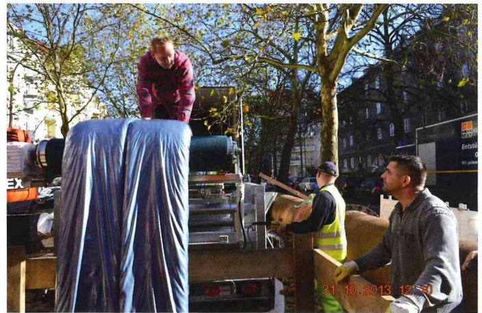
Die automatische Falteinrichtung bereitet den Liner optimal für den Einzug vor.
